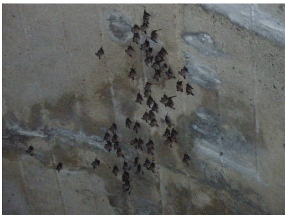
Fig. 6. Colonia de R.euryale en el techo de unos de los túneles
