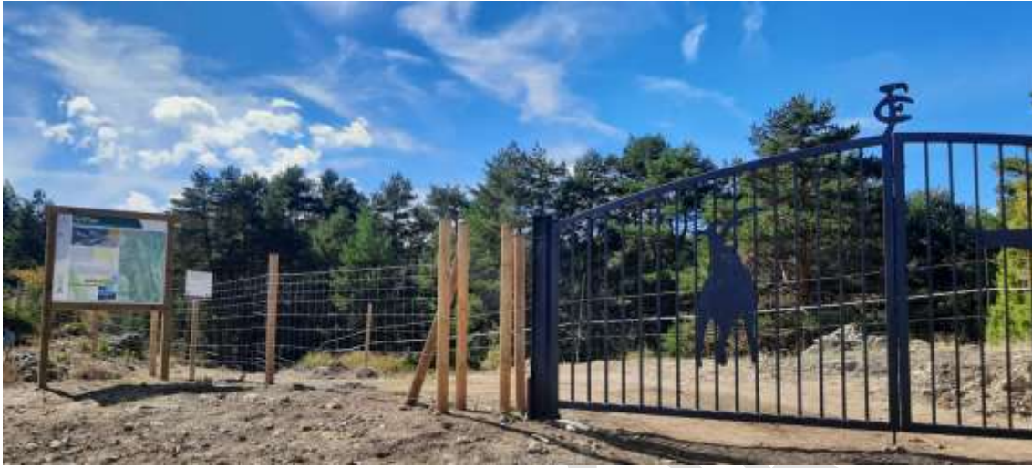
Mejora infraestructura en finca la Campana. Cerramiento, depuradora.
