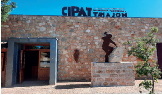
Figura 1-1 Fachada del CIPAT, en Tamajón.
