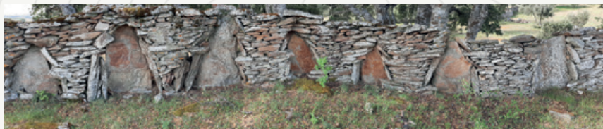
Figura 4-1 Cerca hincadera visible de camino a Villares de Jadraque.
