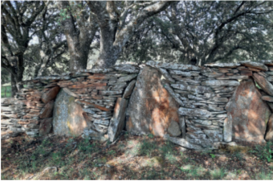
Figura 4-4 Muro de piedras hincaderas.
