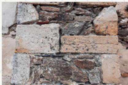
Figura 7-2 Detalle de una de las esquinas de la iglesia de Bustares. Se aprecia la diferente forma de los bloques de gneis y de caliza, en función de sus características físicas.
