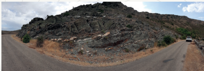
Figura 3-1 Vista del talud de la carretera descrito en la parada 3.
