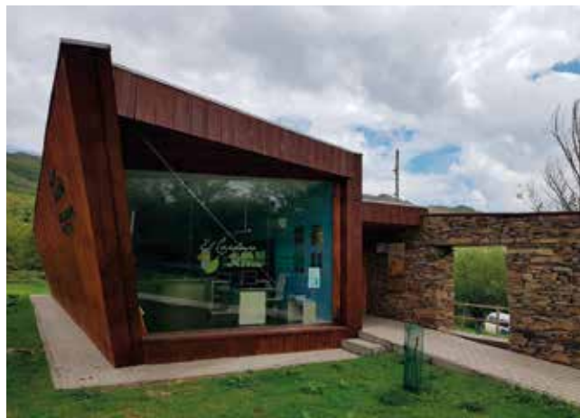
Figura 7-1. Fachada del Centro de Visitantes.
