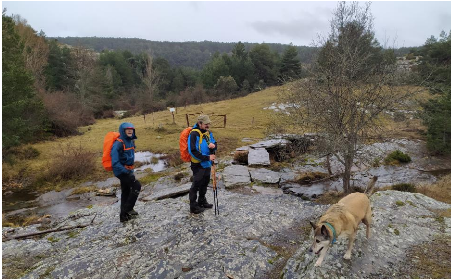
Puente del arroyo del Poyato en Condemios de Abajo, llamado puente de Aldeanueva.
