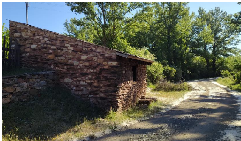
Fragua de Condemios de Abajo, a la entrada del pueblo, junto al camino y una de las fuentes.
